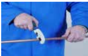
1.- Corte de tubo 1.- Cortar o tubo
