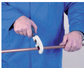
1. Corte de tubo 1. Cortar o tubo
