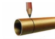
3. Marcar profundidad inserción 3. Marcar profundidade insercion
