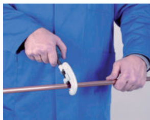
1. Corte de tubo 1. Cortar o tubo
