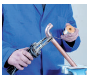
5. Aplicación de la soldadura 5. Aplicação da soldadura
