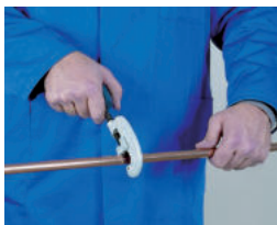
1. Corte de tubo 1. Cortar o tubo
