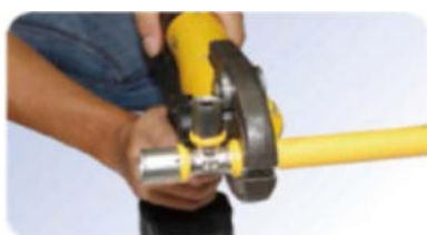
4 - Prensado de tubo y accesorio. Utilizar mordazas tipo "U". 4 - Prensar o tubo e o acessório, utilizando mordças do tipo "U"
