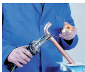
5. Aplicación de la soldadura 5. Aplicação da soldadura
