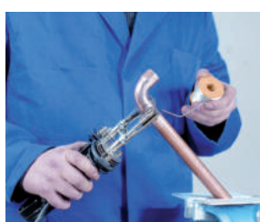
5. Aplicación de la soldadura 5. Aplicação da soldadura
