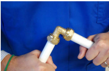
5. Montaje finalizado 5. Montagem terminado
