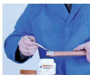
4. Aplicación del decapante 4. Aplicação do decapante
