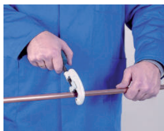
1. Corte de tubo 1. Cortar o tubo
