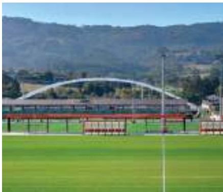
Instalaciones de Lezama Athletic Club (Vizcaya)
