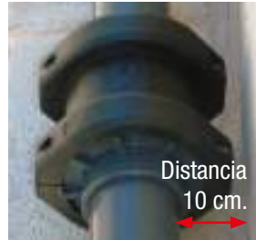
Retención lineal Sistema NETVITC SYSTEM®
