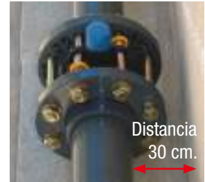
Retención lineal Sistema Tradicional
