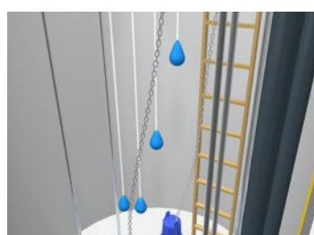
Interruptores de nivel.
