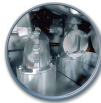
Válvulas antirreflujo de humos de cada módulo térmico
