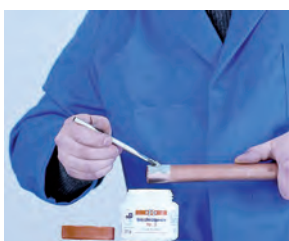
4. Aplicación del decapante 4. Aplicação do decapante
