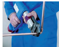
6. Prensado 6. Prensado
