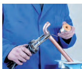
5. Aplicación de la soldadura 5. Aplicação da soldadura
