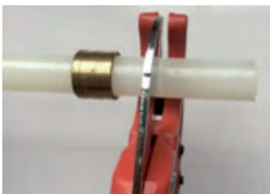
3. Cortar el tubo en ángulo recto. 3. Cortar o tubo em ângulo recto.
