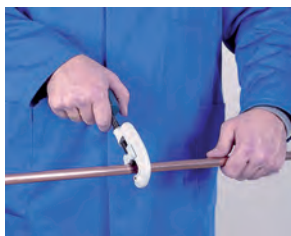
1. Corte de tubo 1. Cortar o tubo
