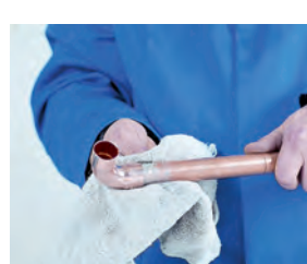
6. Limpieza final 6. Limpeza final
