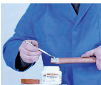
4. Aplicación del decapante 4. Aplicação do decapante
