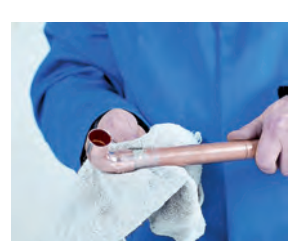
6. Limpieza final 6. Limpeza final
