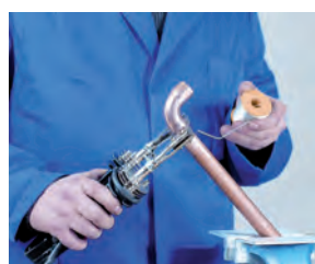
5. Aplicación de la soldadura 5. Aplicação da soldadura
