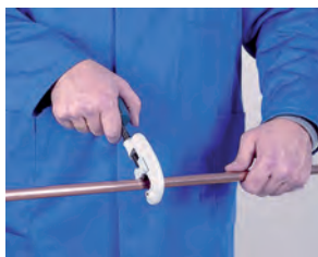
1. Corte de tubo 1. Cortar o tubo
