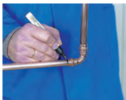
5. Marcar la inserción 5. Marcar o ponto da inserção
