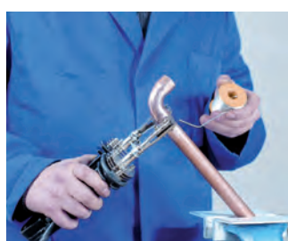
5. Aplicación de la soldadura 5. Aplicação da soldadura
