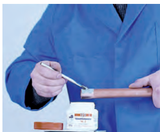
4. Aplicación del decapante 4. Aplicação do decapante
