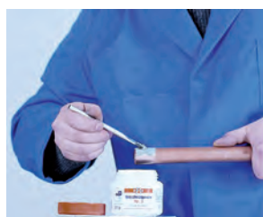
4. Aplicación del decapante 4. Aplicação do decapante
