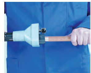
3. Limpieza exterior del tubo 3. Limpeza exterior do tubo
