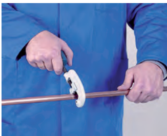
1. Corte de tubo 1. Cortar o tubo
