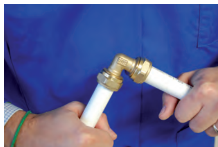
5. Montaje finalizado 5. Montagem terminado
