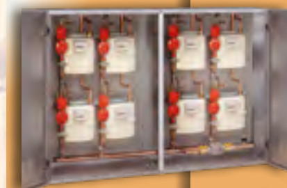
Ejemplo: Armario con batería 2+2+2+2
