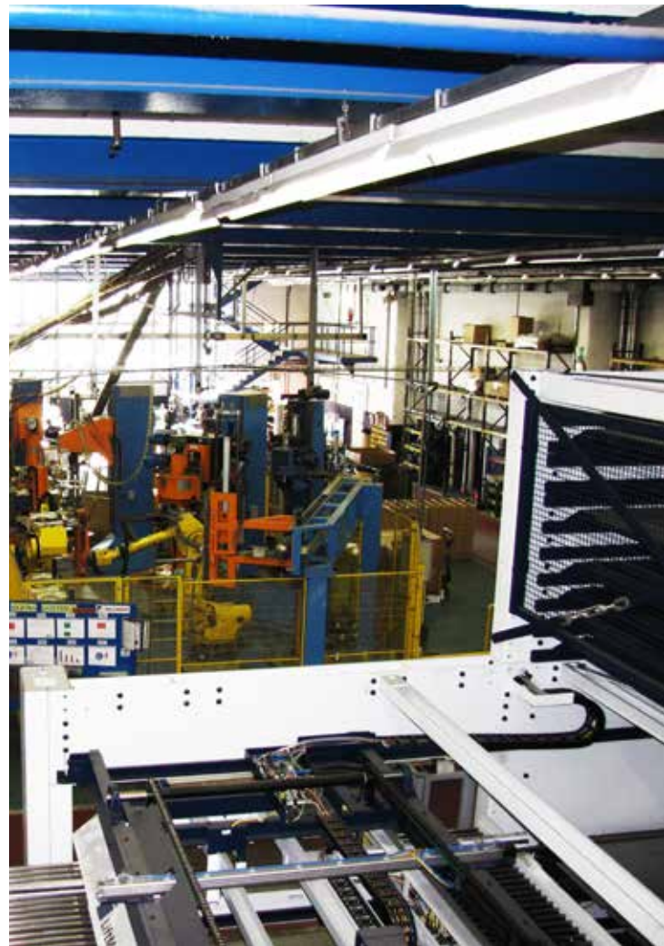
Interior instalaciones Negarra
